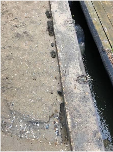
Overzicht van de gaten.
