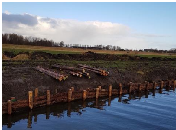
De aanleg van de paaltjes met wiepen ertussen. De aarde die op de kant ligt wordt tussen de wal en de afrastering gestort, zodat de oever glooiend wordt
